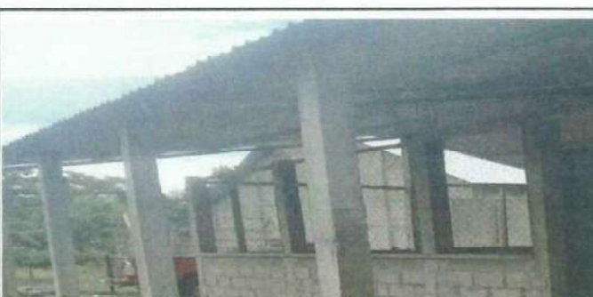
Foto 6: Se observa que el techo se encuentra en mal estado, lo que provoca filtraciones de agua durante la época de lluvias.
